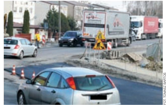
Połączenie drogi technicznej od strony ulicy Bolimowskiej z ul. Warszawską, w czasie układania nowej nawierzchni.
