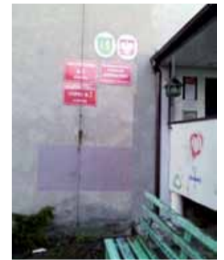
MOS ma zaplecze sanitarne, własną kuchnię, kilkadziesiąt łóżek oraz dużą świetlicę.
