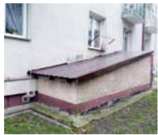
Założono nowy daszek nad wejściem do części magazynowej jednego z bloków.
