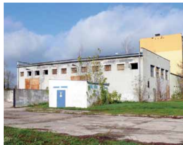
Kotłownia przy bloku nr 44 na os. Bratkowice.
