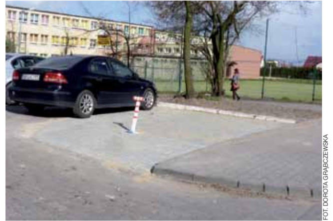
W miejsce usuniętego drzewa ułożono kostkę polbrukową, robiąc stanowisko do handlowania ze słupkiem, by kierowcy nie parkowali.
