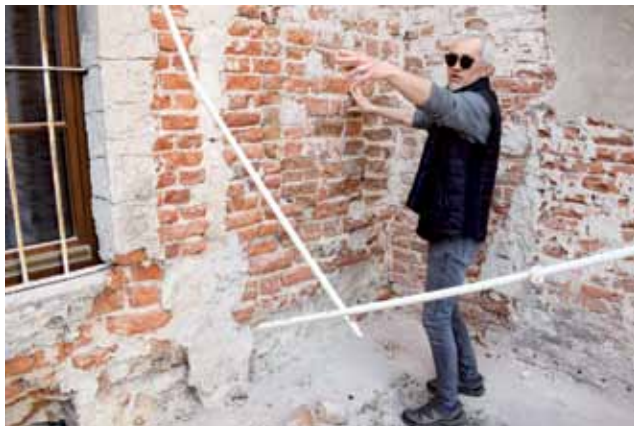
Ściana od strony wschodniej jest świadectwem dynamicznych przemian w konstrukcji budynku w XVII i XVIII wieku.
