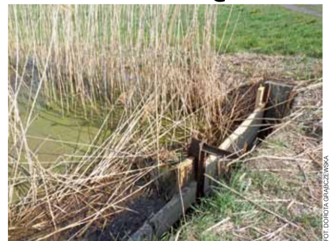
Ważną sprawą do zatrzymania wody w ziemi są drobne budowle melioracyjne, jak ta zastawa wykonana w Woli Kałkowej przez Spółkę Wodną Bedlno.
