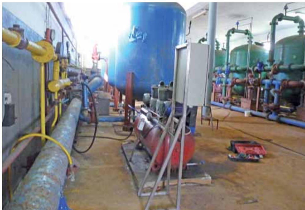
Stacja Uzdatniania Wody w Pniewie jest stara i bardzo awaryjna. W środę, 28 kwietnia, rozpoczęto montaż nowej elektryki na stacji, która ma ograniczyć awaryjność.
