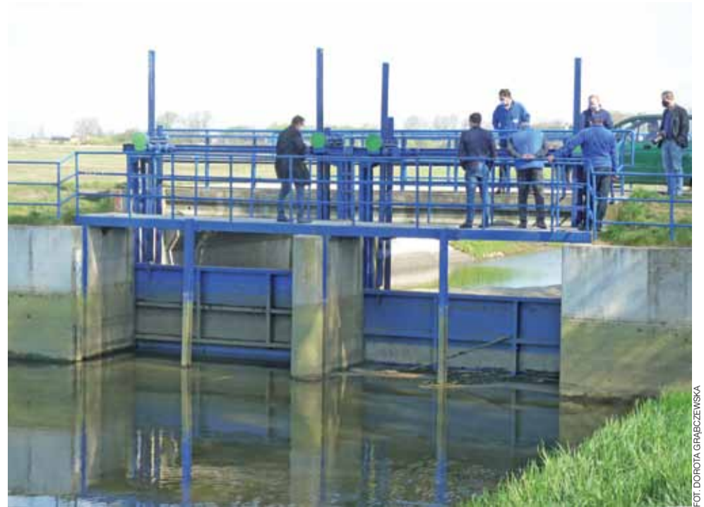
Jaz na rzece Moszczenicy koło Orłowa jest opuszczany i podnoszony ręcznie. W nocy z poniedziałku na wtorek ktoś spuścił wcześniej spiętrzoną wodę.
