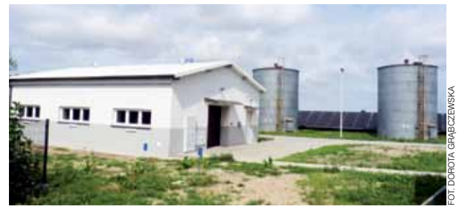
Modernizacja SUW w Oporowie zakończyła się z 2,5-miesięcznym opóźnieniem. Teraz gmina chce obciążyć wykonawcę karami umownymi za nieterminowe zakończenie prac.
