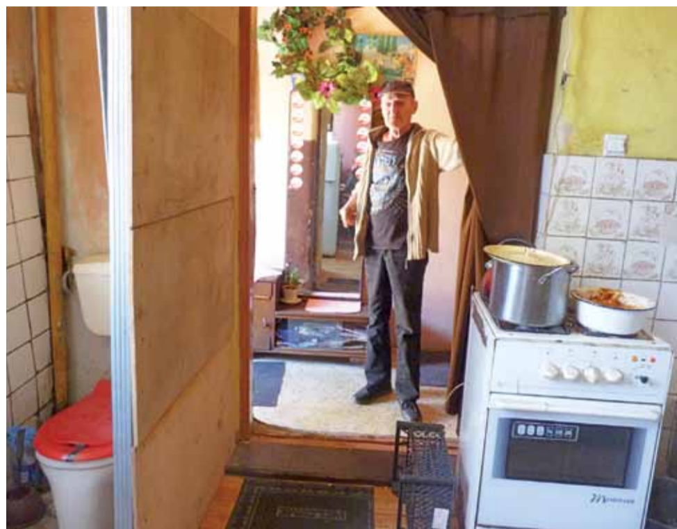
Edward C. w reakcji na brak działań ze strony administratora mieszkania komunalnego SZB wystawił uszkodzone drzwi do mieszkania i zawiązał je do administracji. Zamiast drzwi wisi kotara.
