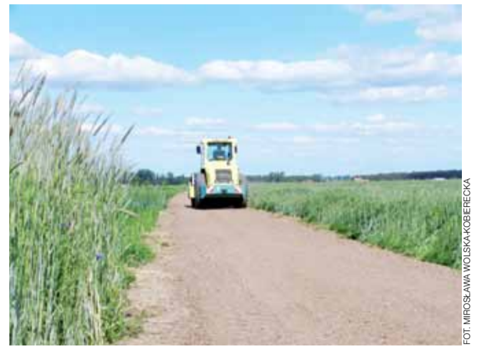
29 maja z wykorzystaniem pozyskanego od firmy Trakt materiału utwardzona została droga dojazdowa do pól w Maurzycach.
