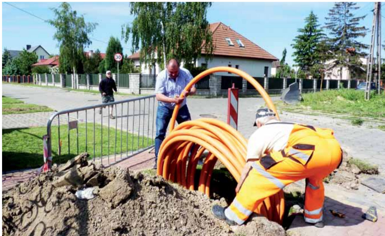
Rury o średnicy 63 mm są wciągane pod ziemię wzdłuż ulicy Krasickiego w Żychlinie. Pracownikom pomaga nawet pracodawca Sylwester Odolak.
