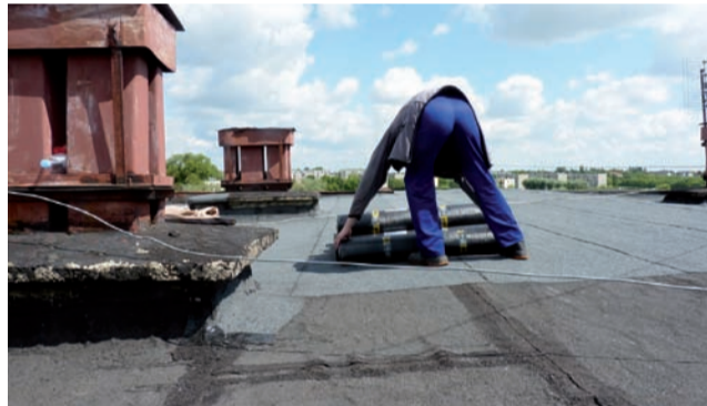
Pracownicy spółdzielni układają papę termozgrzewalną na bloku Konopnickiej 1.
