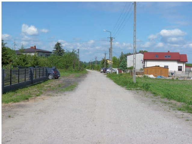
Do końca sierpnia mieszkańcy ulicy Dolnej mają mieć nową nawierzchnię asfaltową.
