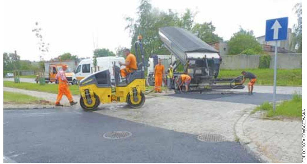
Drogowcy w ubiegły wtorek zarówno przed wjazdem jak i na wjeździe na parking przy ul. Orłowskiego w Żychlinie ułożyli masę bitumiczną
