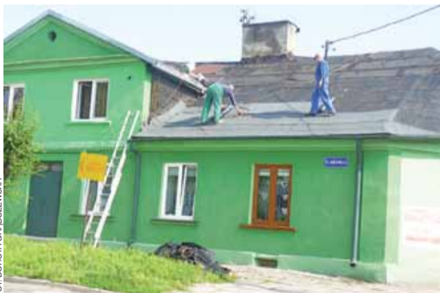
Od kilku dni pracownicy SZB kryją papą dach na kamienicy przy JP11.
