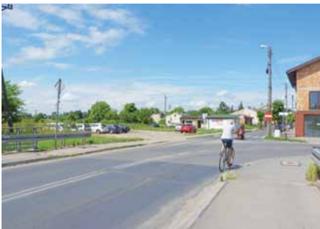
KWP w Łodzi analizuje nową lokalizację budowy komisariatu w Żychlinie na placu koło mostu przy ul. Narutowicza.
