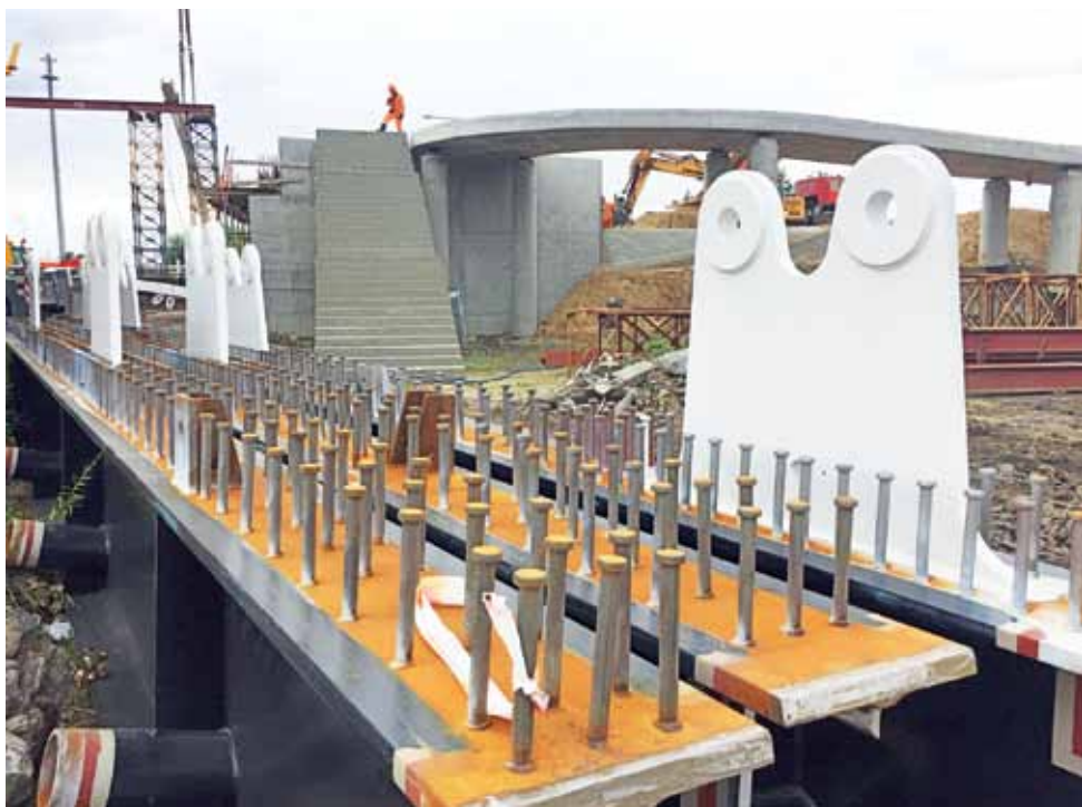
Belki przyszłej jezdni. Widać zaczepy lin nośnych.
