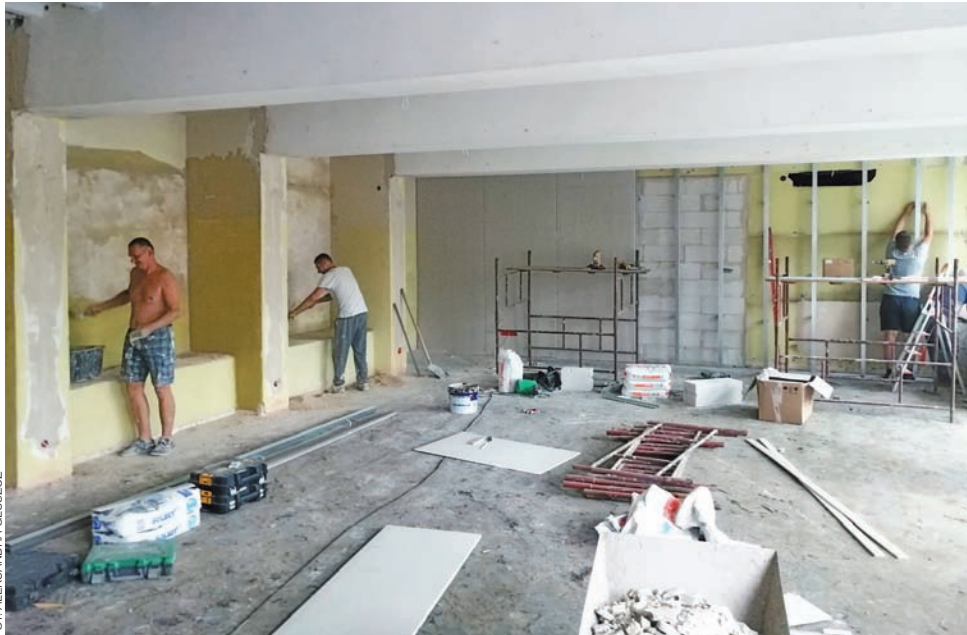
Trwa remont sali kameralnej w Żychlińskim Domu Kultury.
