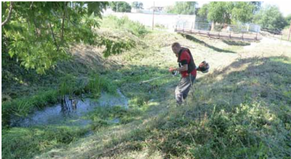
Pracownicy Spółki Wodnej w Bednie wycinali krzaki i trzcinę na odcinku rzeki Studwi przepływającej przez Żychlin.
