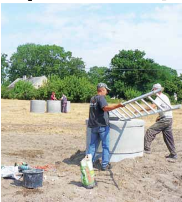
Od tygodnia pracownicy z robót publicznych, przy wsparciu gminnego konserwatora i Marka Olby z UG Pacyna, pracują nad odbudową nowych studni kanalizacji ściekowej.
