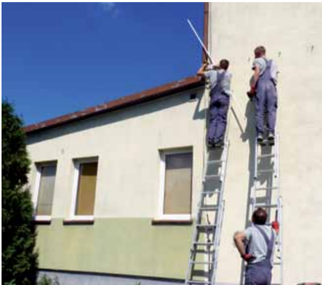
Firma z Gostynina rozpoczęła remont Gminnego Ośrodka Kultury w Bedlnie. Zaczęto od zamontowania kamer na zewnątrz budynku.
