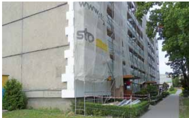
Pierwszym docieplanym w tym roku jest blok Łąkowa 3. Na ściany kładziona jest warstwa styropianu o grubości 15 cm.
