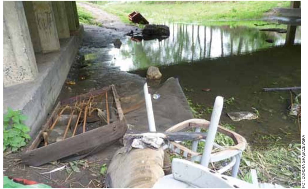
Tak wyglądał teren pod mostem nad rzeką Słudwią, w ciągu ulicy Narutowicza.
