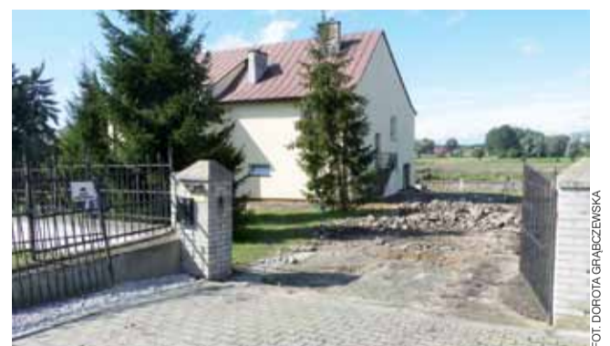
Trwają prace wokół plebanii w Pacynie. Stare betony zostały skute.
