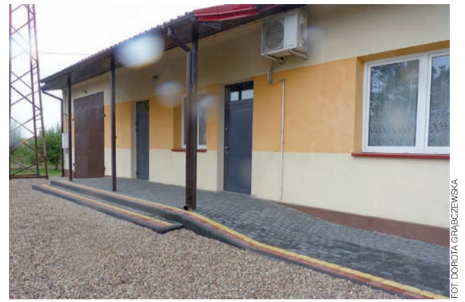
Przed świetlicą wiejską w Orłowie Kolonii jest już estetycznie. Nowe schody i podjazd dla niepełnosprawnych.
