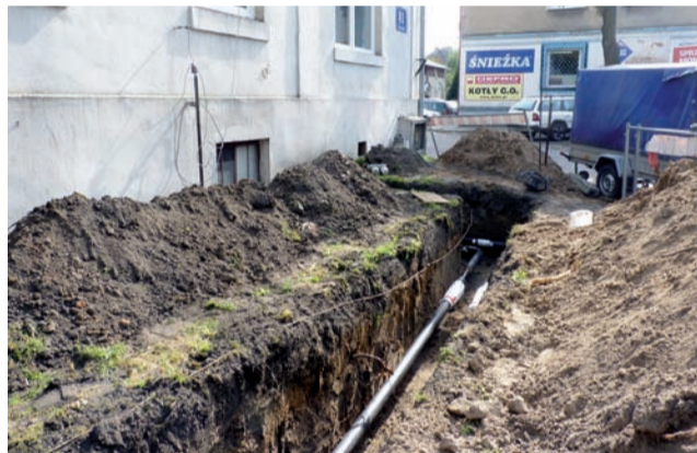
Firma z Ostródy podłącza do miejskiego ciepła blok Narutowicza 81, dawniej tzw. porodówki.
