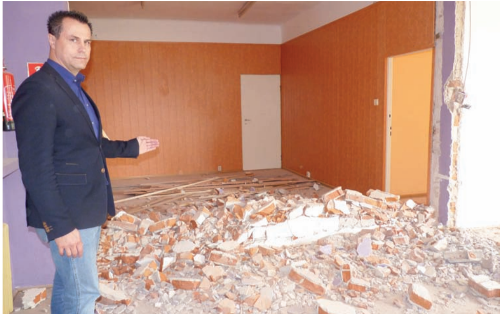
Dyrektor Jarosław Pucek pokazuje, że na półpiętrze Gminnego Ośrodka Kultury zostały wyburzone ścianki działowe, by zrobić jedno duże pomieszczenie na bibliotekę gminną.
