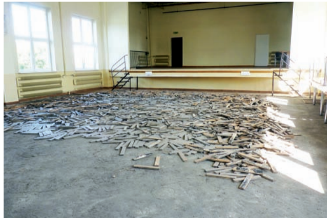
W sali widowiskowej GOK Bedno zerwano już stary parkiet. Będzie nowy z drewna egzotycznego.
