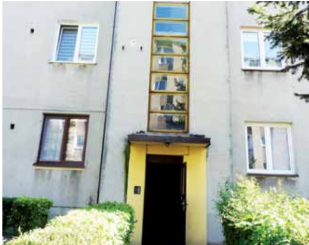
W połowie października będą wymienione okna w bloku Okoniewskiego 1. Część z nich zostanie zamurowana.
