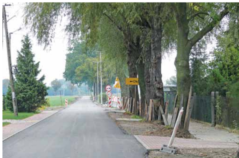
Na odcinku pomiędzy DK 92 a szkołą jest już położony nowy asfalt.
