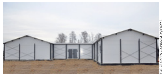
Nowa chlewnia umożliwiła chów trzody w cyklu zamkniętym i ma wydzieloną część dydaktyczną.
