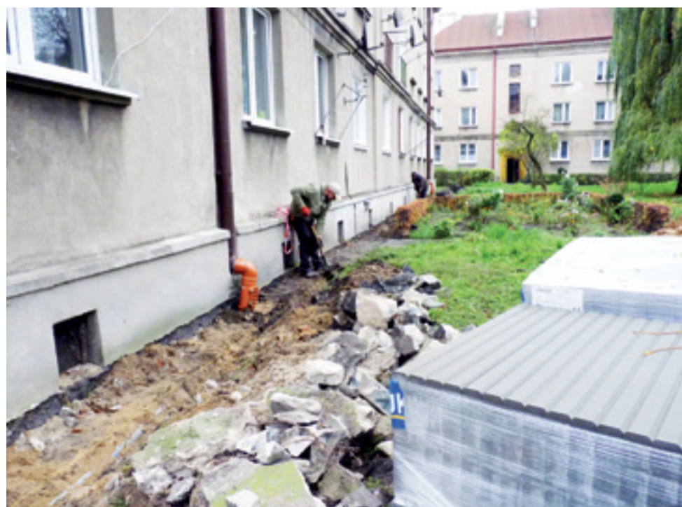
Wzdłuż bloku Waryńskiego 2 robiona jest opaska odwadniająca.
