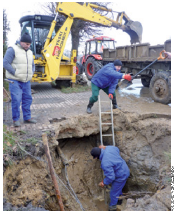
Pracownicy Samorządowego Zakładu Budżetowego usuwali awarię wodociągu w ul. Dobrzelińskiej
