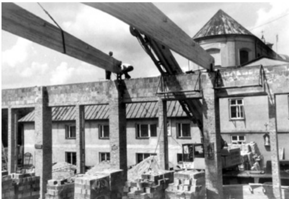
Maj 1998 r. Prace przy budowie sali gimnastycznej dla szkoły pijarskiej.
