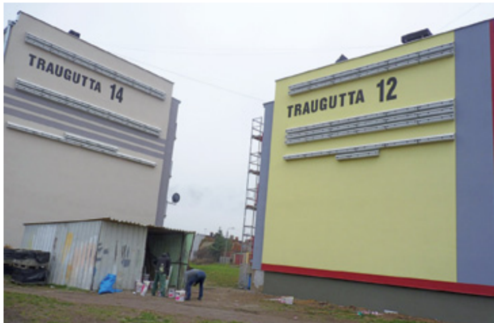
Piotr Jarosz, prezes Spółdzielni mieszkaniowej w Żychlinie, przedłużył wykonawcy zakończenie prac do końca kwietnia. Główne prace zostały zakończone, została kosmetyka.
