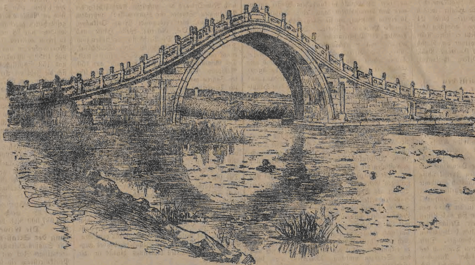
Die Marmorbrücke von Peking.
