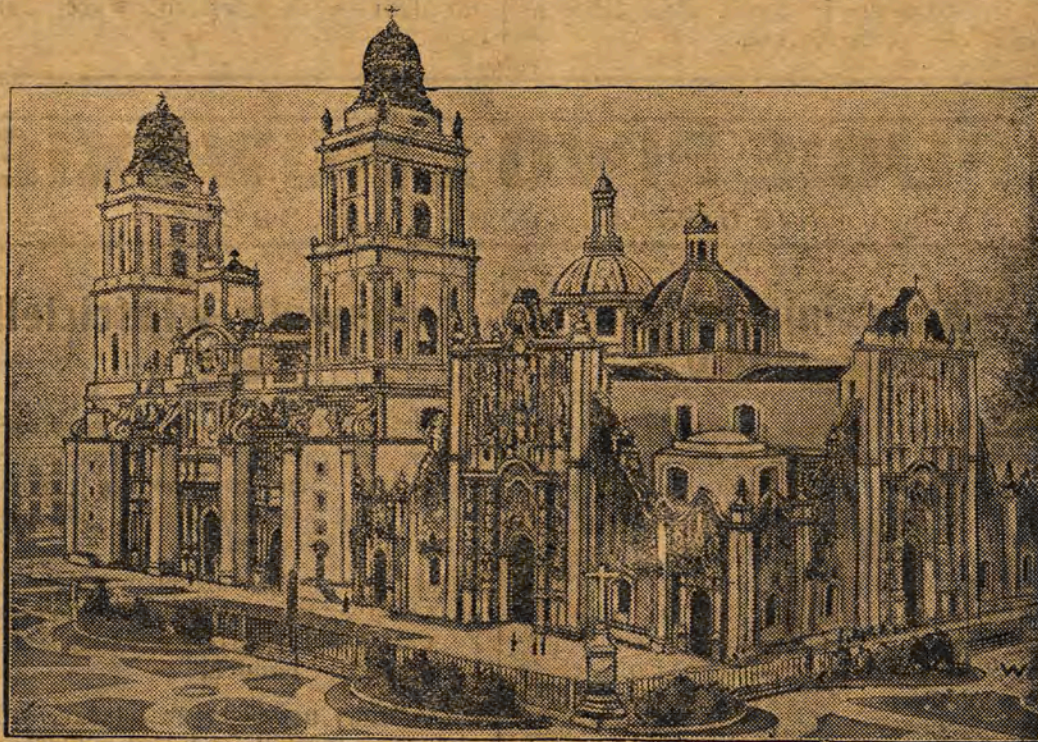
Katedra w Meksyku, której budowa trwała od r. 1573 do r. 1667 jest obecnie zajęta przez wojsko.
