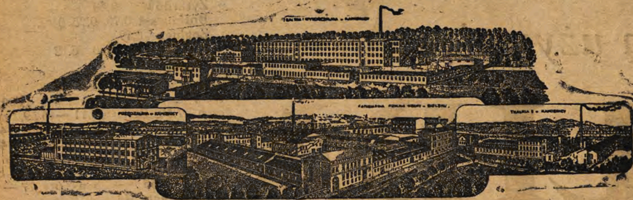
(Ogólny widok fabryki).
