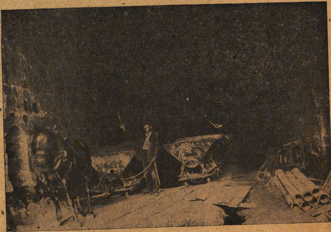
JAK SIĘ BUDUJE TUNEL POD WARSZAWĄ
