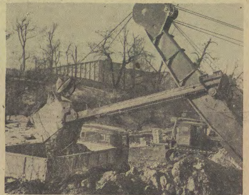
W końcu stycznia br. rozpoczęto prace przy budowie nowej części Centralnego Parku Kultury na Powiślu w Warszawie.
