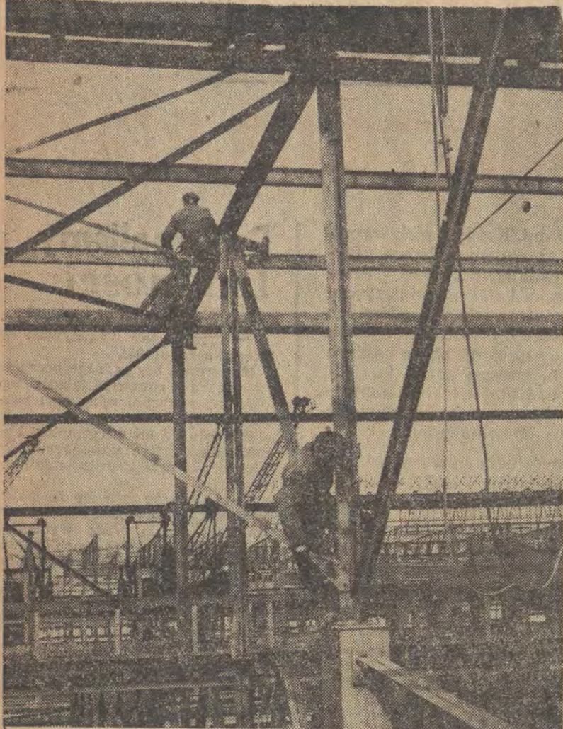
Na budowie kombinatu Nowej Huty
