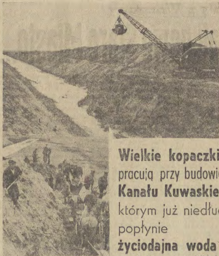
Na zdjęciu u góry: potężna kopaczka pracuje przy budowie głównego Kanału Kuwaskiego.
