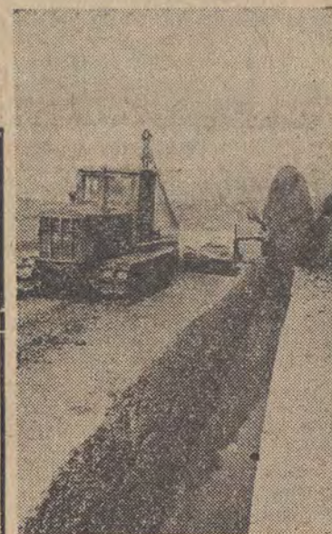
Zakłady wydobywania torfu wyposażone są w najnowocześniejsze maszyny. Na licznych terenach eksploatacji torfu wszystkie prace są zmechanizowane. Na zdjęciu: pogłębianie rowu osuszającego przy pomocy specjalnej maszyny na terenie zakładów wydobywania torfu w Tootsi (Estońska SRR). Fot. — CAF
