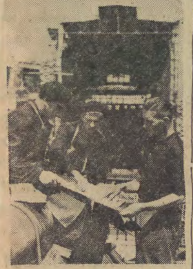
Na zdjęciu: mistrz montażu kotta siłowni Emanuel Smela. Omawia wykonanie pracy przez spawaczy Kazimierza Osieckiego i Jana Gwczarczyka. Brygady wchodzące w skład zespołu Smeli zobowiązały się w Czynie Lipcowym skrócić prace montażowe o 8 dni. W głębi siłownia w budowie. CAF — Fot. Zygm. Wdowiński.
