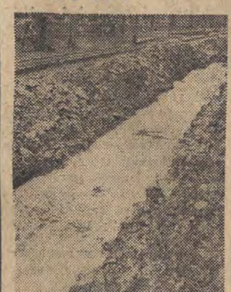
Wskutek ulewnej deszczu rowy kanalizacyjne zamieniły się szybko w wartko płynące „szczęśliki”. Na zdjęciu: zalane kanały kanalizacyjne przy ul. Mielczarskiego.
