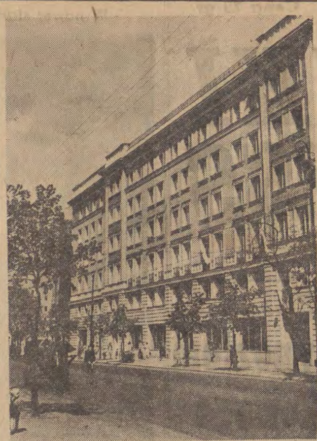
Coraz więcej bloków oddają do użytku mieszkańcom stolicy budowniczo druciej część Marszałkowskiej Dzielnicy Mieszkaniowej. Na zdjęciu: nowe bloki MDM na odcinku od Pl. Unii Lubelskiej do Placu Zbawiciela. CAF fot. Szyperko
