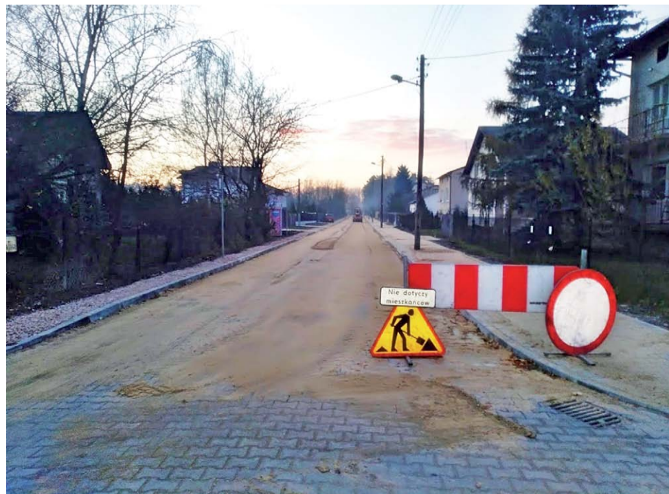
Budowa ul. Wyszyńskiego w Głownie to inwestycja, która już została zrealizowana.
