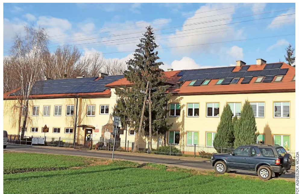
Instalacja fotowoltaiczna została wykonana na budynku szkoły w Kocierzewie Północne, a także dwóch innych szkołach i Urzędzie Gminy.
