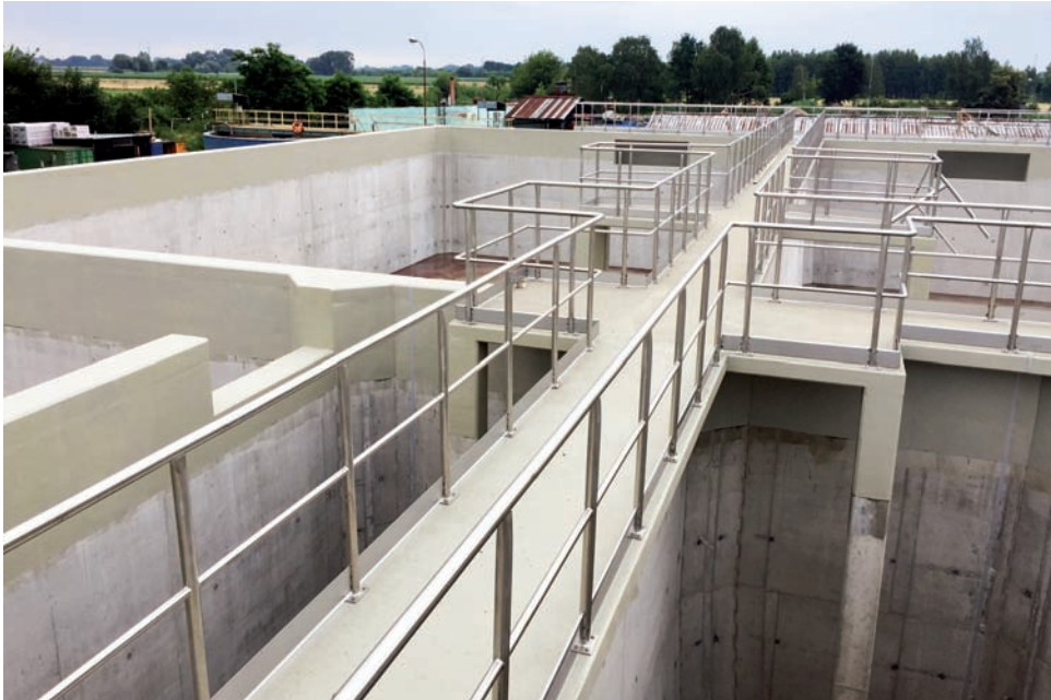
Modernizacja oczyszczalni ścieków to – już nie pierwszy rok – największy wydatek.
