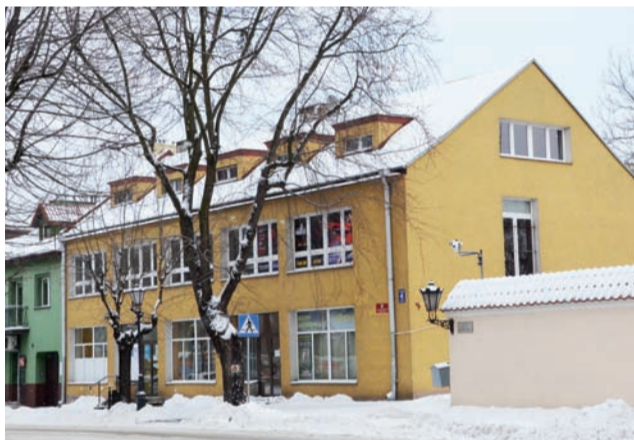
ŁSM planuje wyremontowanie pomieszczeń na II piętrze tego budynku siłami swoich pracowników z brygady remontowo-budowlanej.
