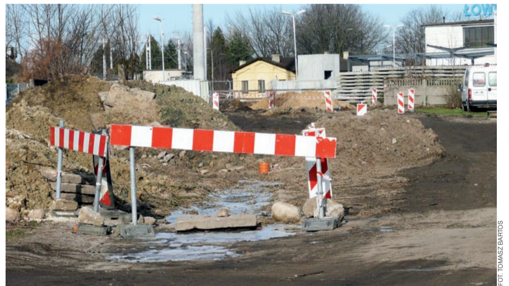
Budowa kanalizacji sanitarnej i deszczowej w ulicy Napoleońskiej wkroczyła na tereny gdzie dotąd mało kto się zapuszczał.
