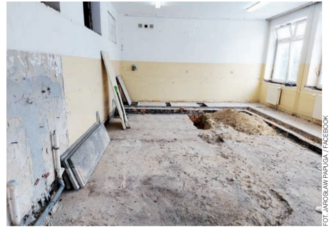
W czerwcu w Dzierzgowku ma ruszyć drugi oddział żłobka. Trwają prace remontowe.
