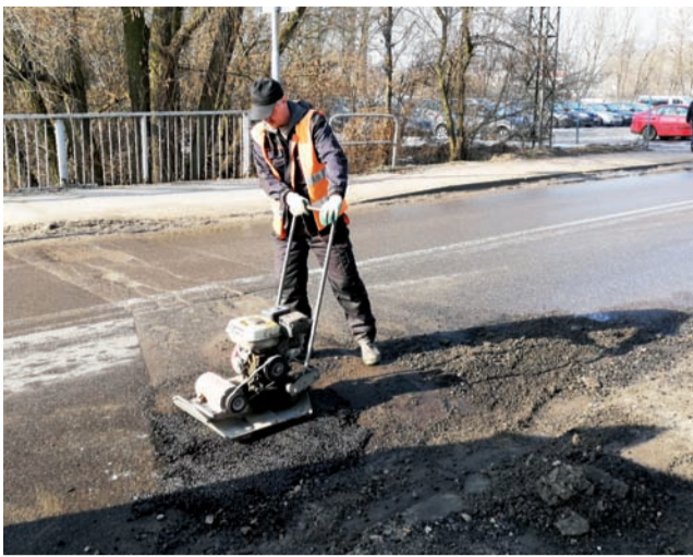
Łatanie dziury powstałej na przyczółku mostu na ul. Mostowej w Łowiczu.
