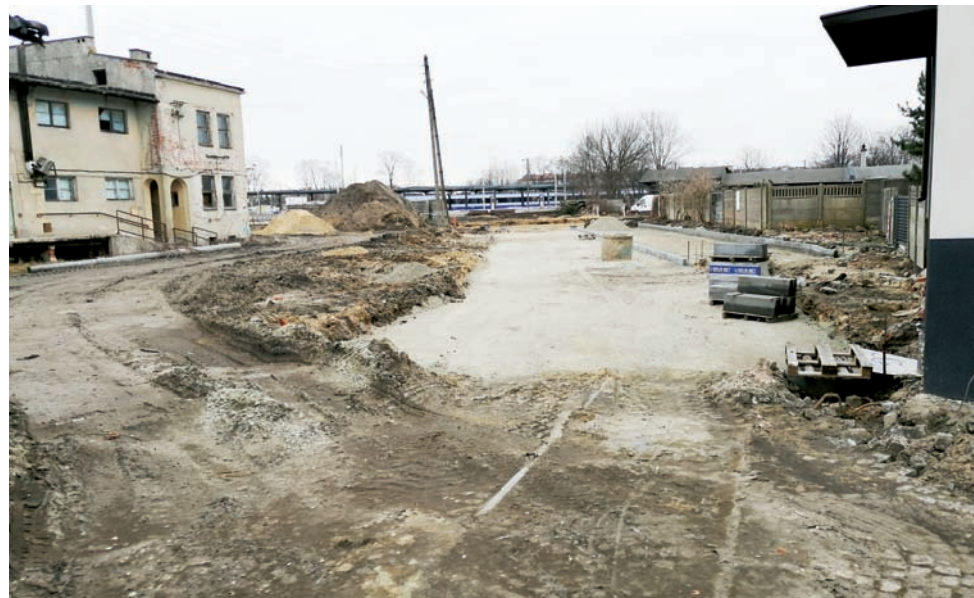
Widok z ul. Magazynowej w kierunku skrzyżowania z ul. Napoleońską, na dole zdjęcia widać granitową kostkę, która nie zostanie wymieniona w ramach trwających prac.
