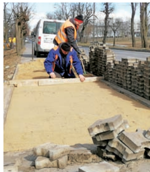
Pracownicy Zakładu Utrzymania Miasta zajmują się w tym tygodniu remontem zniszczonego chodnika wzdłuż ul. Kaliskiej.
