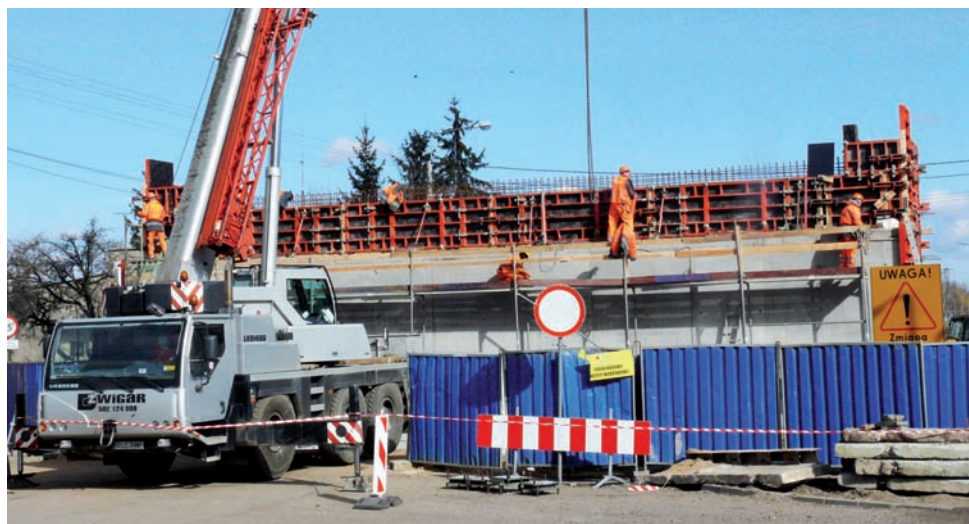
Budowa przyczółka wiaduktu, wyraźnie postępuje z dnia na dzień, we wtorek 9 marca zbrojenie było już w części zalane betonem.
