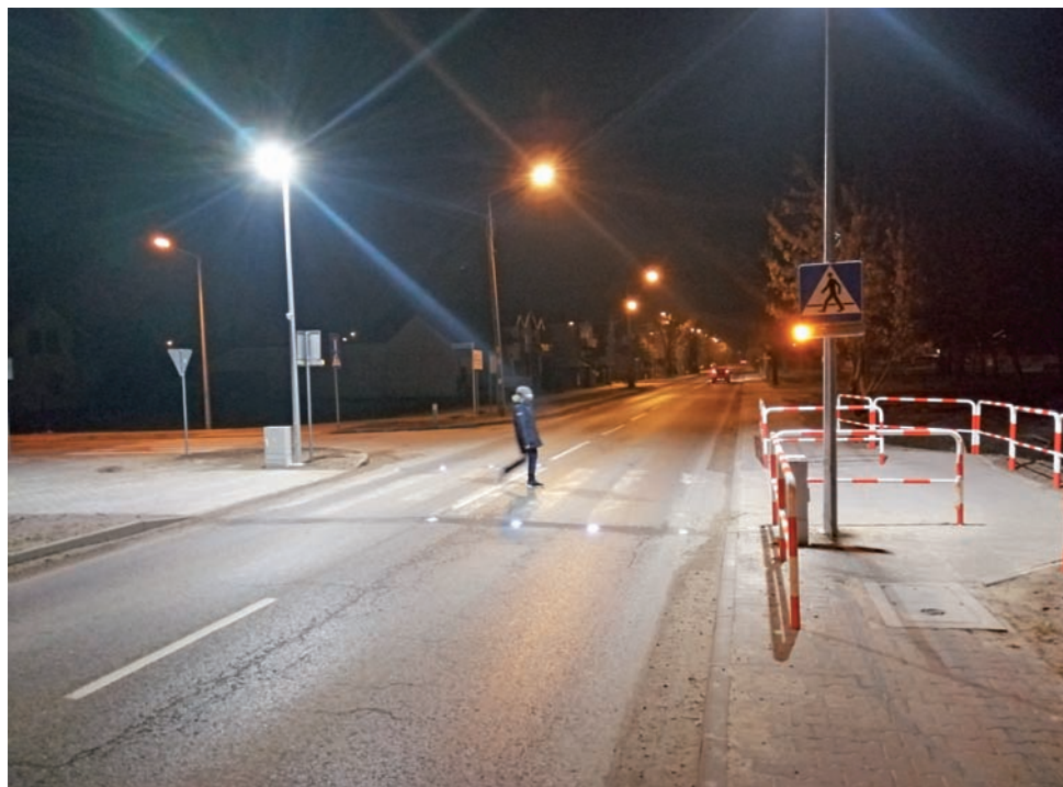
Przejście dla pieszych na ul. Kaliskiej wyposażono w dodatkowe oświetlenie – kocie oczy umieszczone w asfalcie oraz aktywny znak drogowy.
