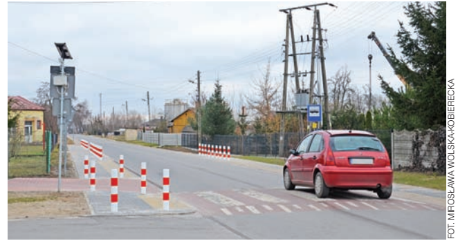
Słupki w rejonie skrzyżowania ustawiono po to, aby kierowcy nie omijali wyniesionego przejścia dla pieszych, wjeżdżając na chodnik.
