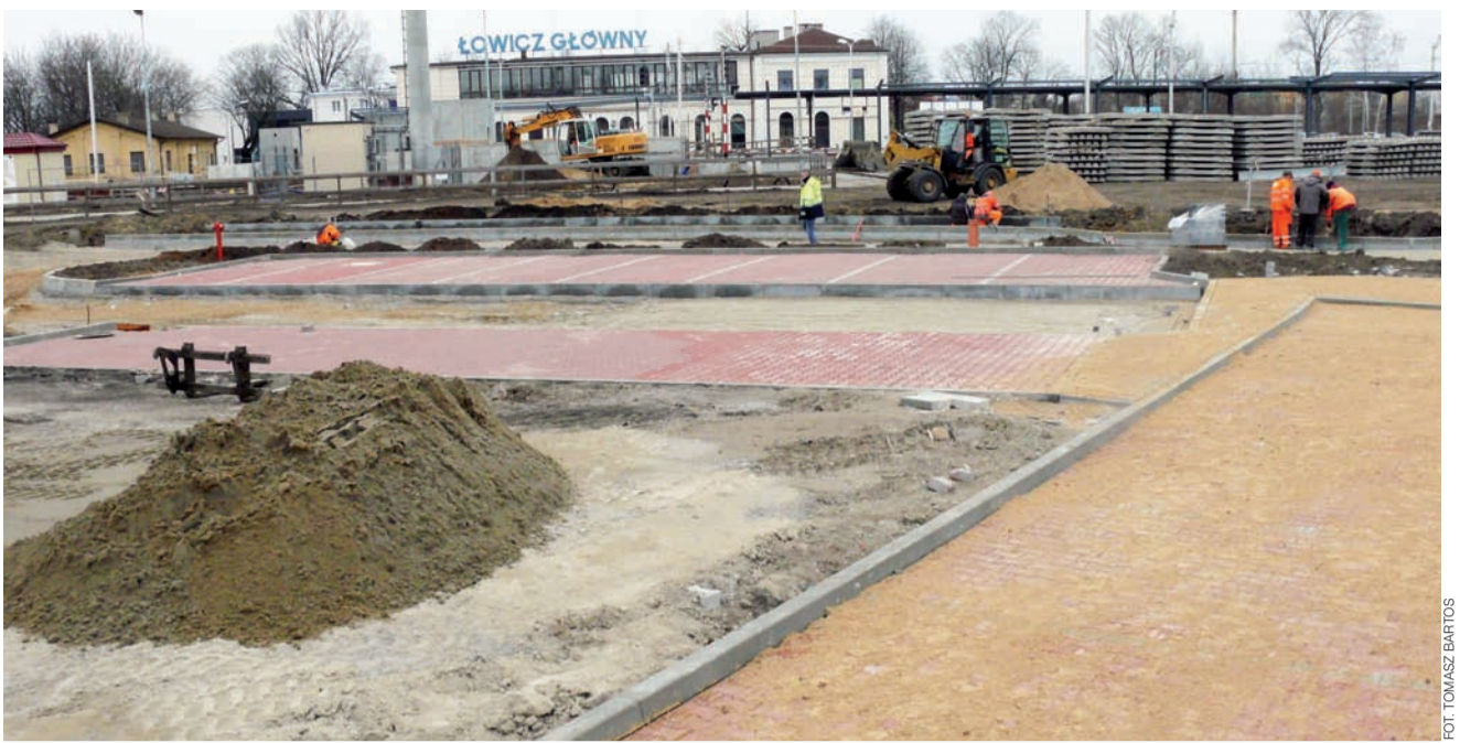
Powstające miejsca parkingowe przy ul. Magazynowej i Napoleońskiej, w tle budynek dworca Łowicz Główny.
