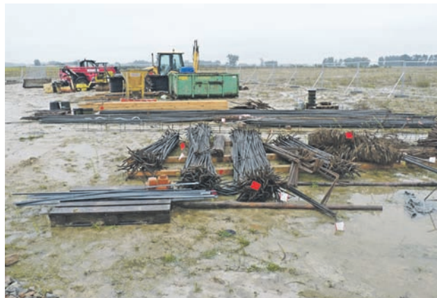
Opuszczony plac budowy w Piaskach Bankowych.
