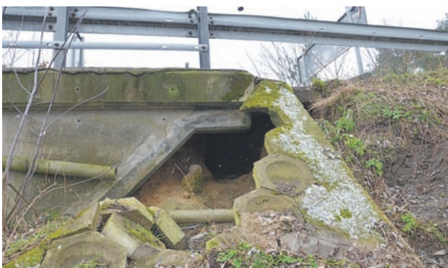
Tak wyglądał uszkodzony przyczółek mostu na Bzurze w Maurzycach w styczniu br.
