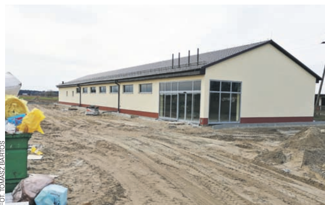
Budynek marketu Dino po dwóch miesiącach już pod dachem.
