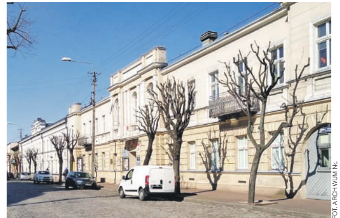
Budynek Łowickiego Ośrodka Kultury przy ul. Podrzecznej w tym roku będzie cieszył odnowioną elewacją.
