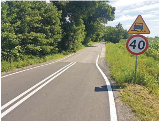
Miejsce, gdzie w 2019 roku zakończyły się prace modernizacyjne na drodze do Miedniewic.
