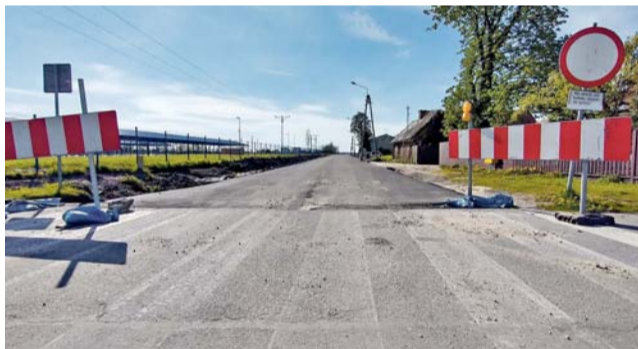
Hillwood rozpoczął od budowy drogi. Na ostatnią warstwę asfaltu trzeba będzie poczekać do zakończenia budowy hal.
