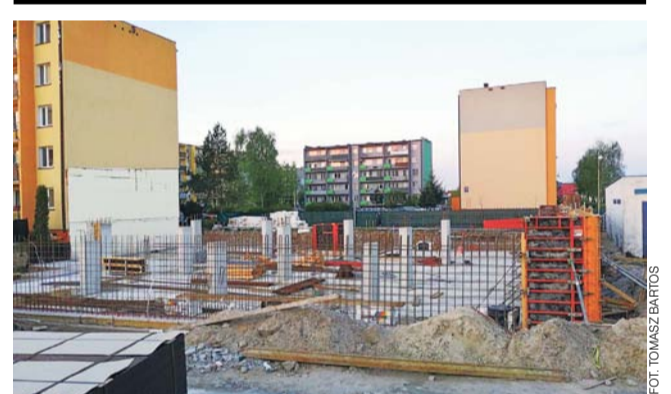
Na Bratkowicach powstaje nowy blok, w którym znajdzie się 45 mieszkań.
