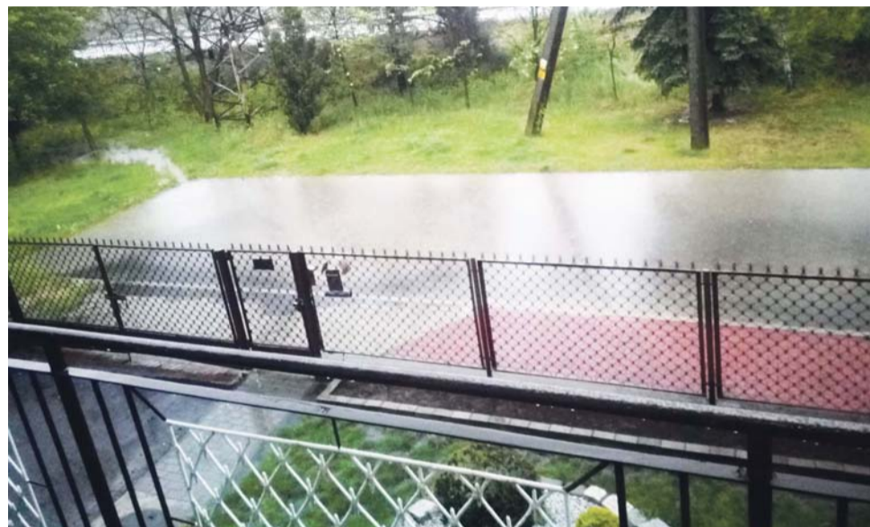
Ulica Wyzwolenia kompletnie zalana wodą podczas opadów.
