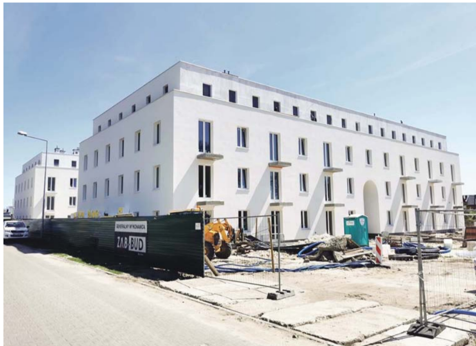
Budowa osiedla mieszkań przy ul. Krudowskiego jest już na zaawansowanym etapie (stan na 12 maja).
