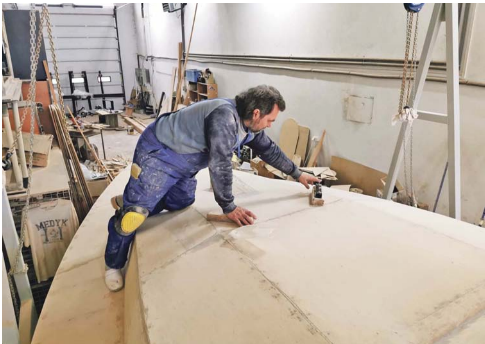
Wygładzanie zewnętrznej ściany i dachu kabiny. Każdy otwór z wkrętem jest dokładnie przykryty szpachlą.
