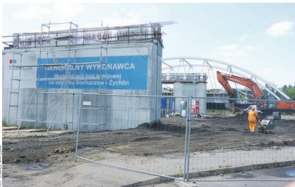
Teren budowy wiaduktu. Zdjęcie z 30 czerwca.
