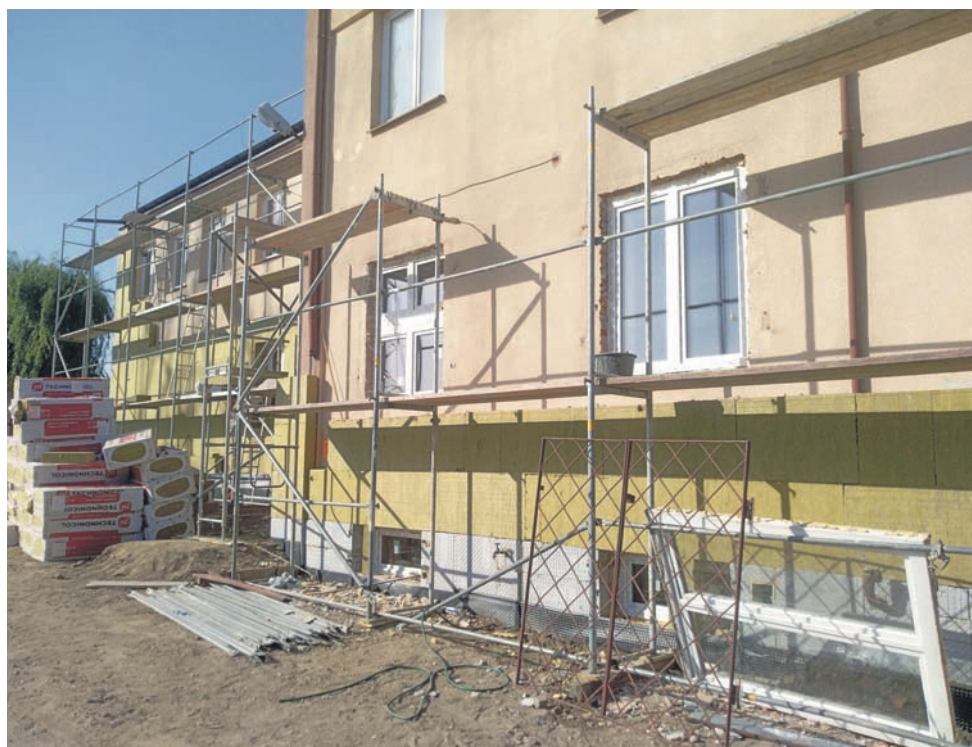
Budynek Urzędu Gminy w Domaniewicach nie należał do najpiękniejszych.
