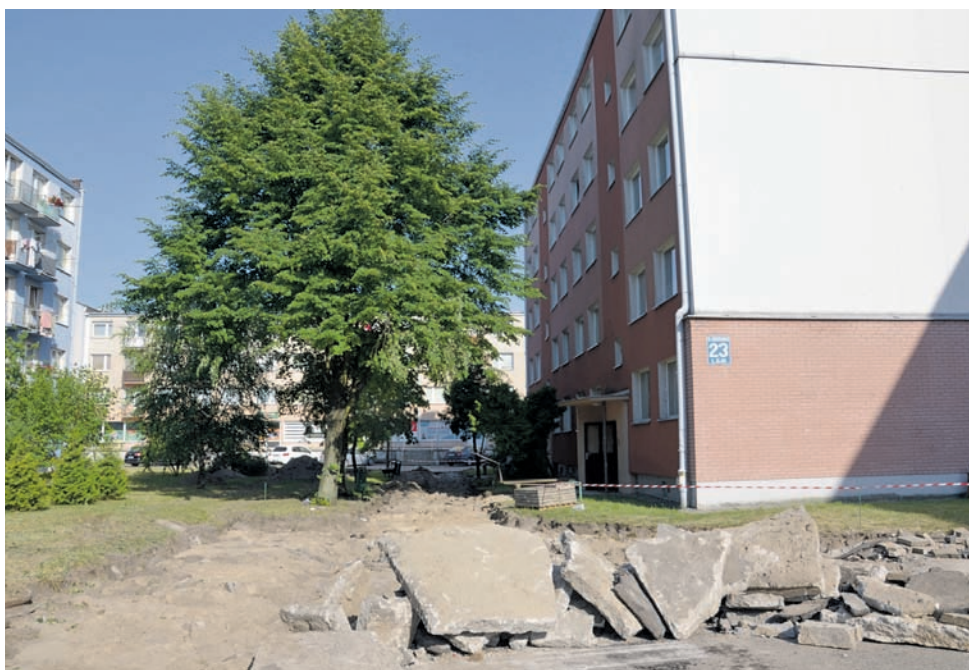
Modernizacja parkingu na os. Dąbrowskiego rozpoczęła się w ubiegłym tygodniu od prac ziemnych.
