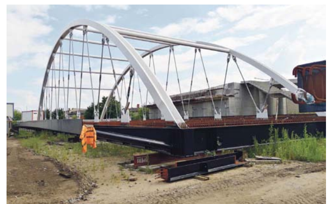
Najcięższy element, który podniesie żuraw, to ta ważąca 250 ton konstrukcja, która zostanie umieszczona na filarach nad torowiskiem.
