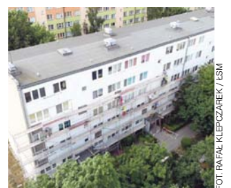
Trwają prace dociepleniowe w blokach Łowickiej Spółdzielni Mieszkaniowej.
