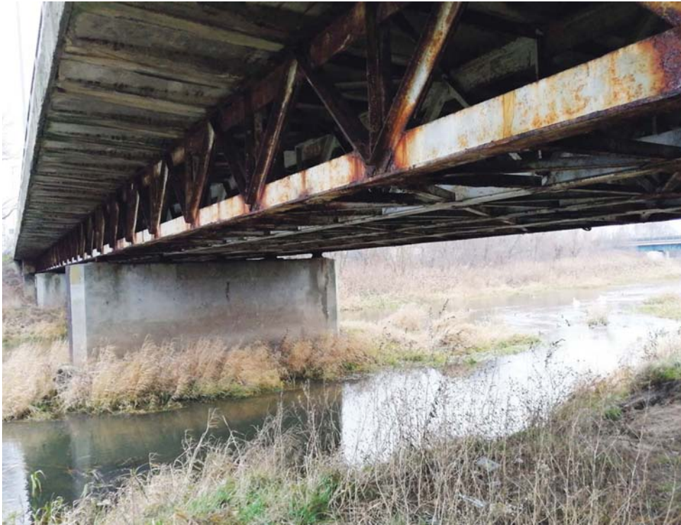
Stary, skorodowany most na Bzurze w centrum Łowicza. Jego modernizacja wydaje się być jednym z priorytetów.
