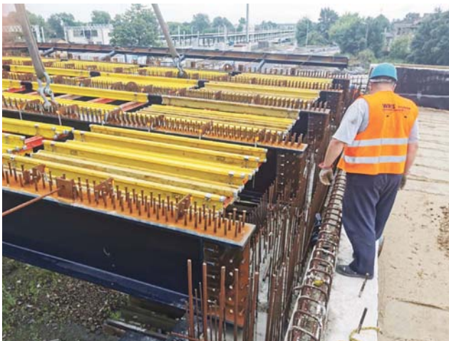
Przęsła już osadzone na podporach.
