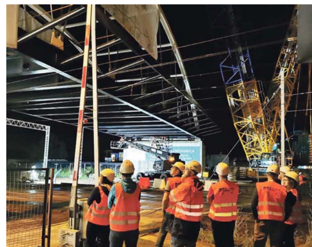
Faza ostatnia: konstrukcja jest osadzona na podporach.
