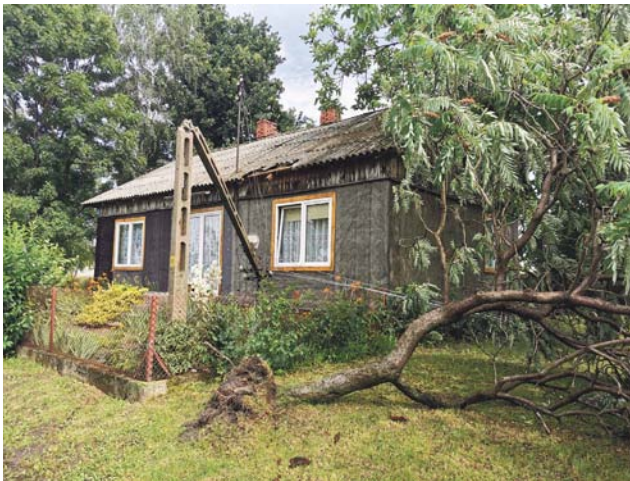
To też obraz zniszczeń w Świerżu I.
