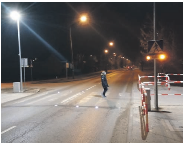
W tzw. „kocie oczy” umieszczone w asfalcie oraz aktywny znak drogowy wyposażone jest już przejście dla pieszych na ul. Kaliskiej w Łowiczu.
