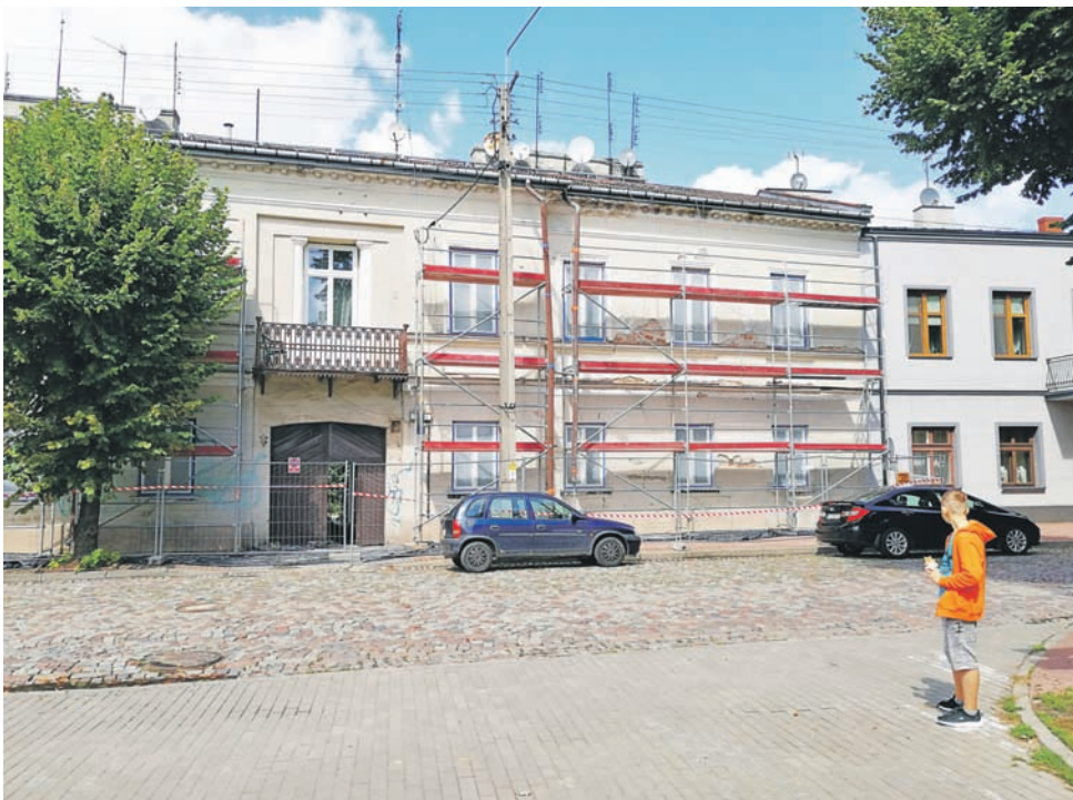
Trwa remont kamienicy przy ul. Podrzecznej 18, w wyniku którego blask odzyska jej elewacja.
