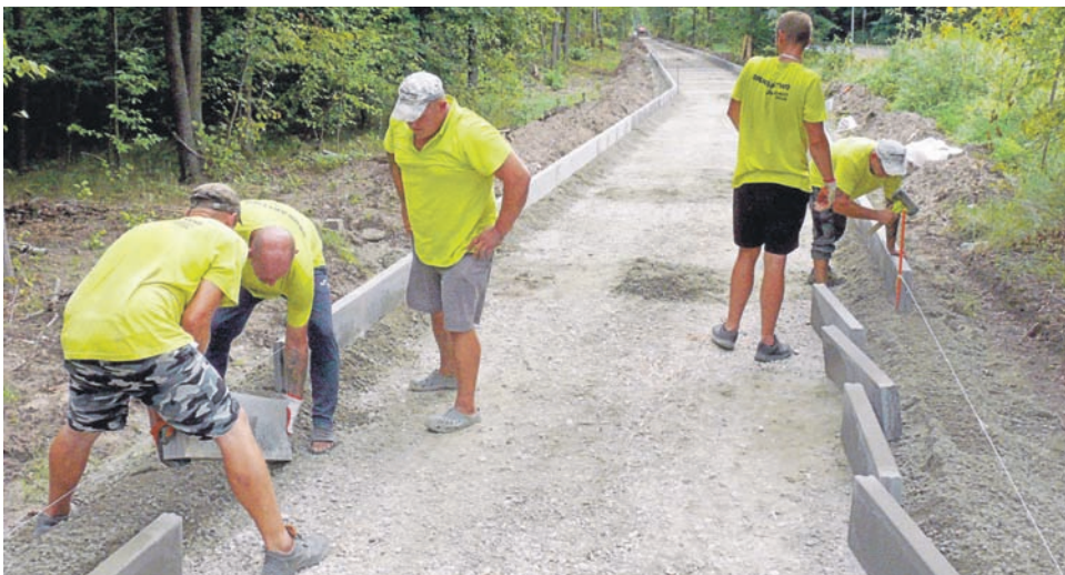
Budowa ścieżki rowerowej posuwa się szybko do przodu, na zdjęciu pracownicy firmy Antonio Bruk z Piotrkowa Trybunalskiego, która jest podwykonawcą prac zleconych firmie Erbedim.
