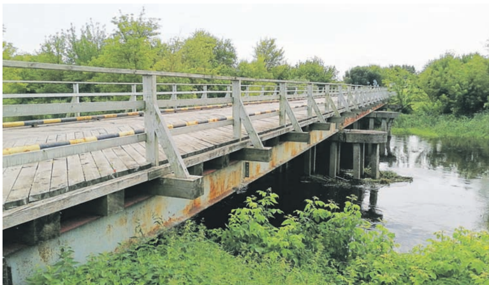
Drewniany most na Bzurze w Kompinie wkrótce zastąpi konstrukcja żelbetowa, po której będą mogły swobodnie przejechać m.in. samochody ciężarowe.
