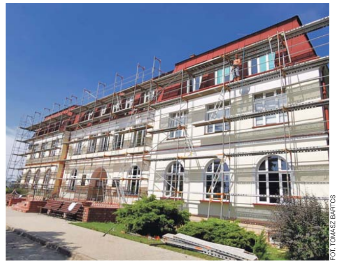
Główny budynek szkoły blichowskiej zasłonięty rusztowania.
