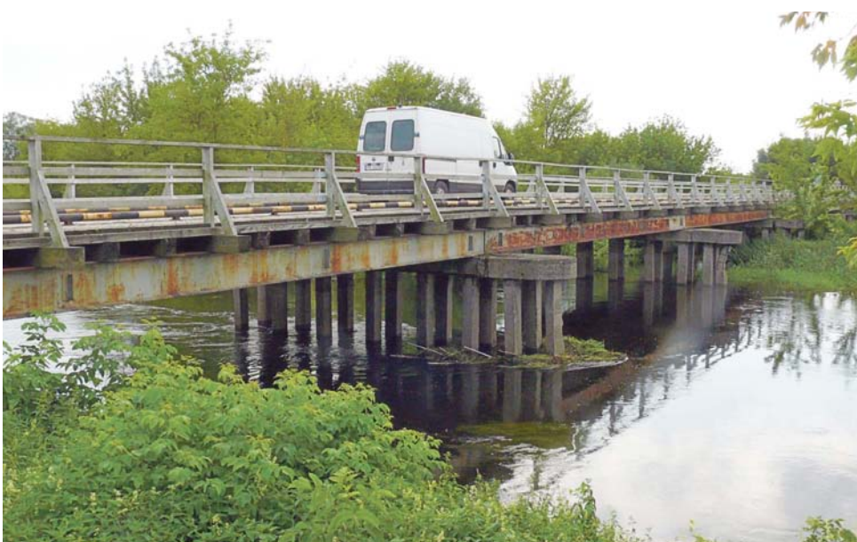
Drewniany most na Bzurze w Kompinie niebawem zniknie.
