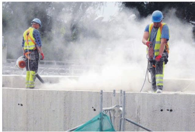
Aktualnie prowadzone są prace nad modernizacją pierwszej z dwóch komór fermentacyjnych.
